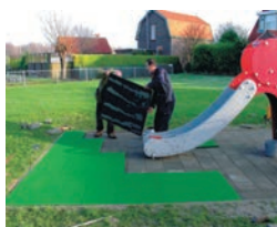
Esempio di posa in opera
